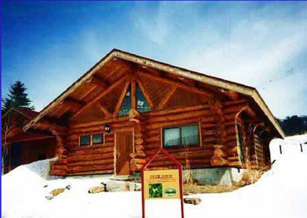
丸太や角材を井桁のように組み上げ、これを壁体とする構造
