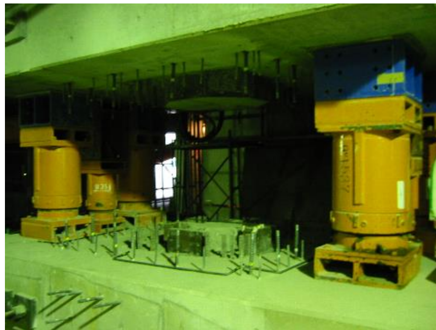
免震部材取付け
