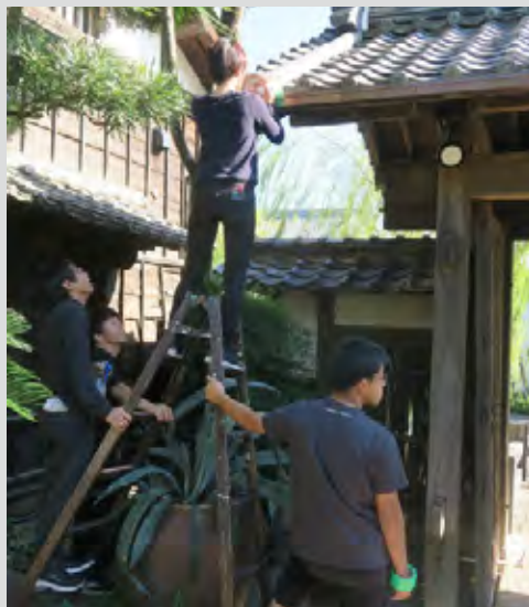
実測調査の様子
