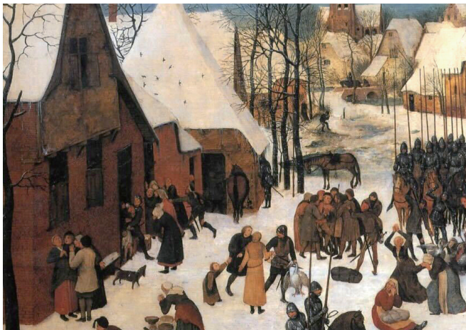
図3 二階を張り出す当時の都市部にみられた住宅形式（「ベツレヘムの嬰兒虐殺」）
